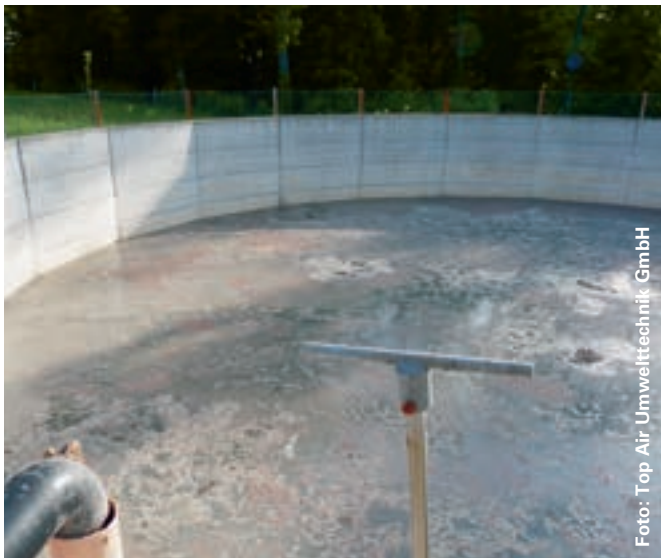
Das offene Beton-Güllesilo ohne Abdeckung
