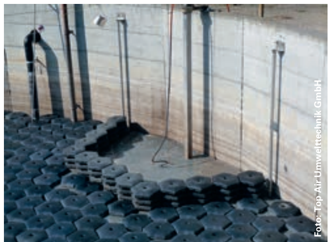
Deutlich sichtbar ist der errichtete Rührwerkschutz, der verhindert, dass die Kunststoffelemente der Matrix-Cover®-Abdeckung beim Rühren angesaugt und beschädigt werden.
