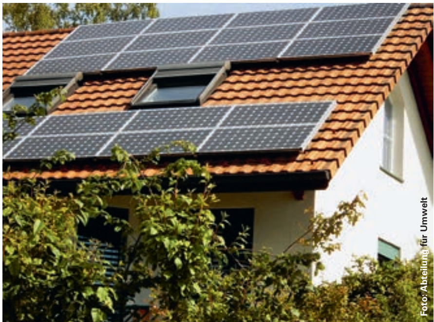
Bei der Reinigung einer Fotovoltaikanlage darf nur reines Wasser ohne Chemikalien verwendet werden, wenn die Dachentwässerung in eine Versickerungsanlage oder ein Oberflächengewässer führt.
