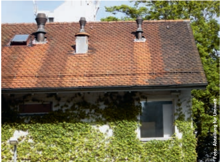
Dach mit Auswaschungen durch Metallinstallationen
