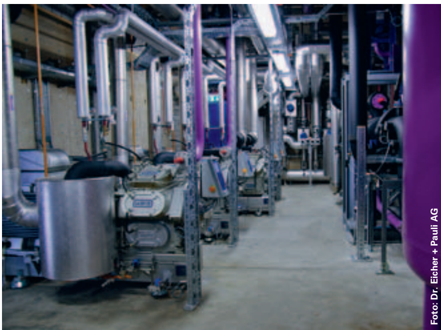
Wärme-/Kälteerzeugungsanlage: 2,5 Megawatt Heizleistung und 1,5 Megawatt Kälteleistung
