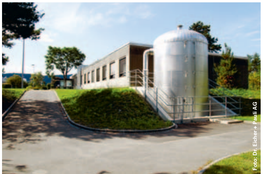
Der Wärmespeicher hat ein Volumen von 65 Kubikmetern.
