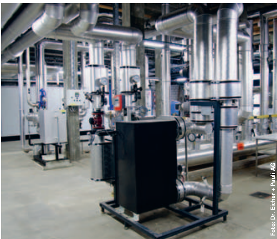
Wärmeübertragungsstation: Hier findet der Wärmeaustausch vom Fernnetz auf die Gebäudeheizung statt.
