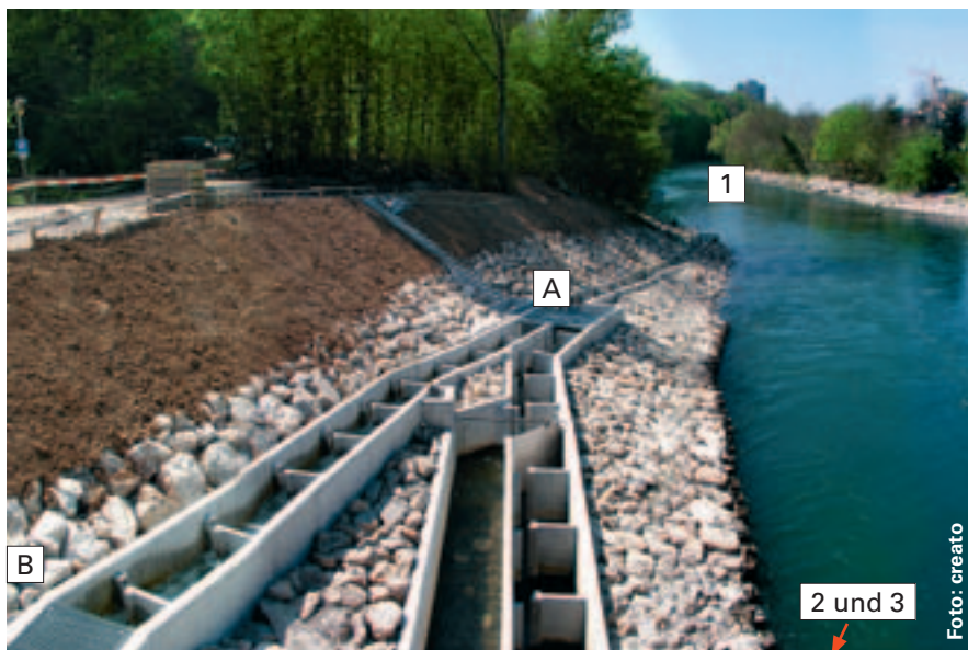
Der neu erstellte Vertikalschlitzpass beim Kraftwerk Kappelerhof:
