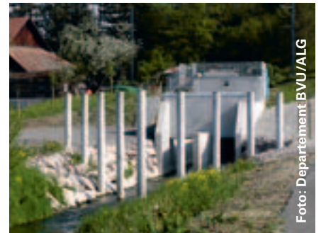
Hochwasserrückhaltebecken Moos in Gontenschwil/Zetzwil: Auslastyp Mönch mit Schacht als Hochwasserentlastung
