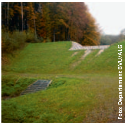
Hochwasserrückhaltebecken Drachtenloch in Villmergen: homogener Schüttdamm mit Durchlassauslauf und Dammscharte
