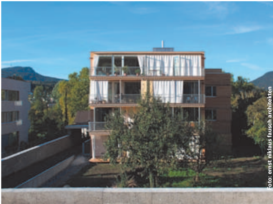
Das erste Minergie®-P-ECO-Haus im Kanton Aargau wurde von Ernst Niklaus Fausch Architekten geplant und realisiert. Das in ressourcenschonender Holzelementbauweise erstellte Mehrfamilienhaus ist zentral gelegen und ermöglicht dadurch eine umweltschonende Mobilität. Eine hohe Wohnqualität für unterschiedliche Lebensphasen und -modelle zu moderaten Kosten – bei möglichst geringer Umweltbelastung – war das Ziel dieses in allen gesellschaftlichen Bereichen nachhaltigen Projektes.
