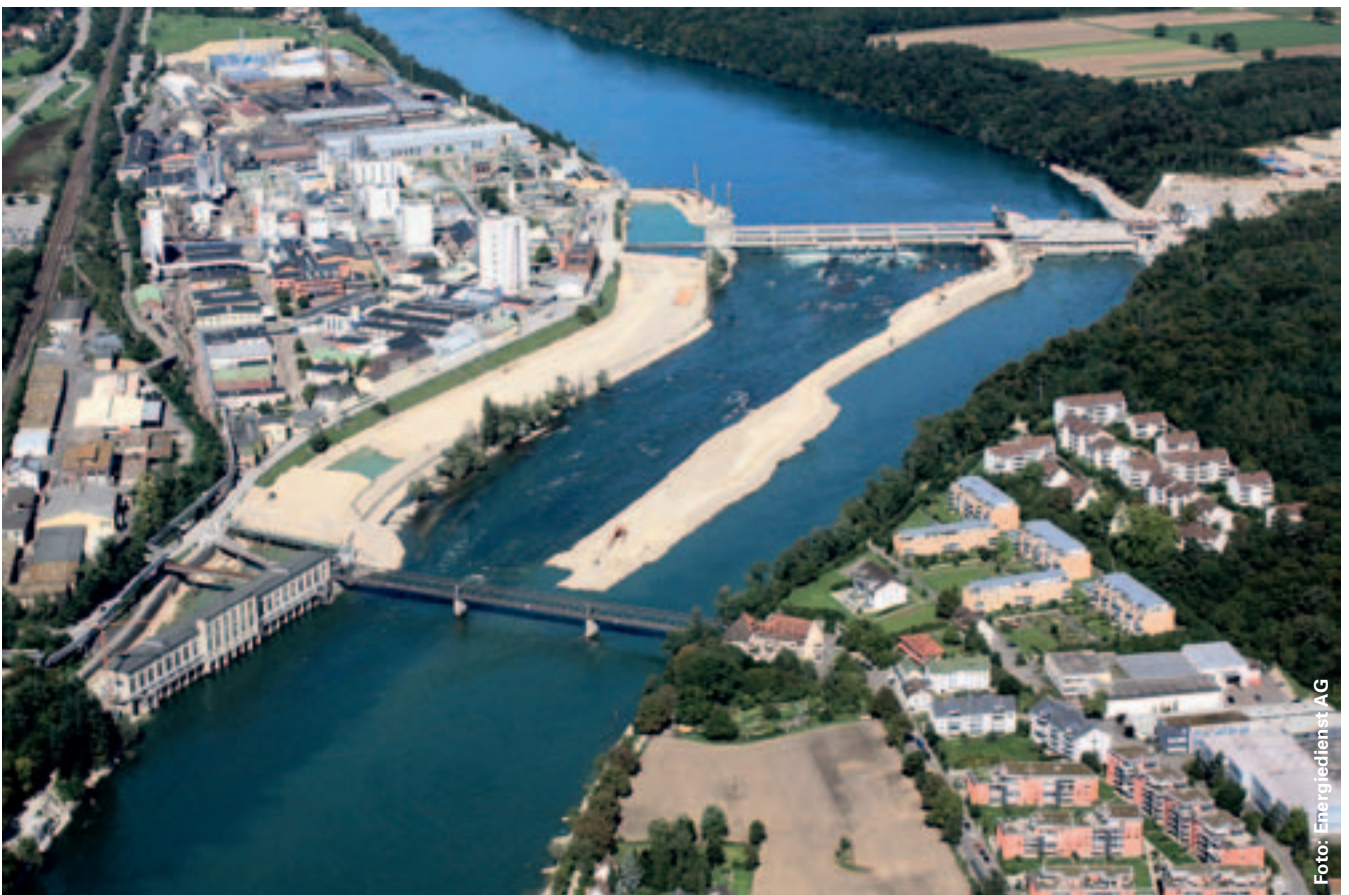
Luftbild der Baustelle Neubau Kraftwerk Rheinfelden von Mitte September 2010: Im neuen Kraftwerk sind zwei von vier Maschinen bereits in Betrieb. In der Rheinmitte ist der Rückbau des Dammes im Gang, welcher für die Rheineintiefung geschüttet wurde. Das alte Kraftwerk ist ausser Betrieb und der Zulaufkanal wird für den Einbau des naturnahen Fischeaufstiegs- und Laichgewässers vorbereitet.
