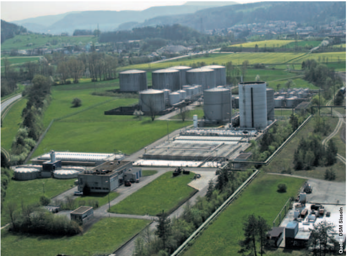
Die Industriekläranlage der DSM Sisseln ist eine der grössten der Schweiz.
