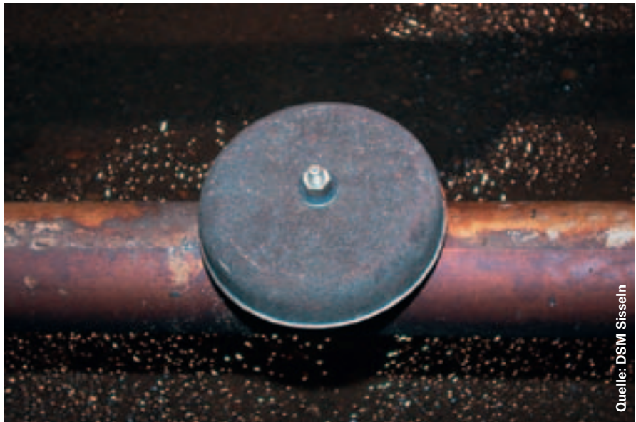
Die Stahlrohre mit den Keramik-Dome-Belüftern sind sehr anfällig für Korrosionsschäden.
