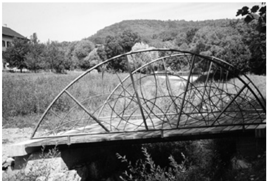
Die neue Brücke über das Umgebungsgewässer.
