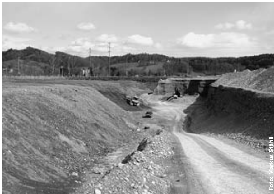
Auffüllerarbeiten in der Kiesgrube Hardmatte in Kölliken
