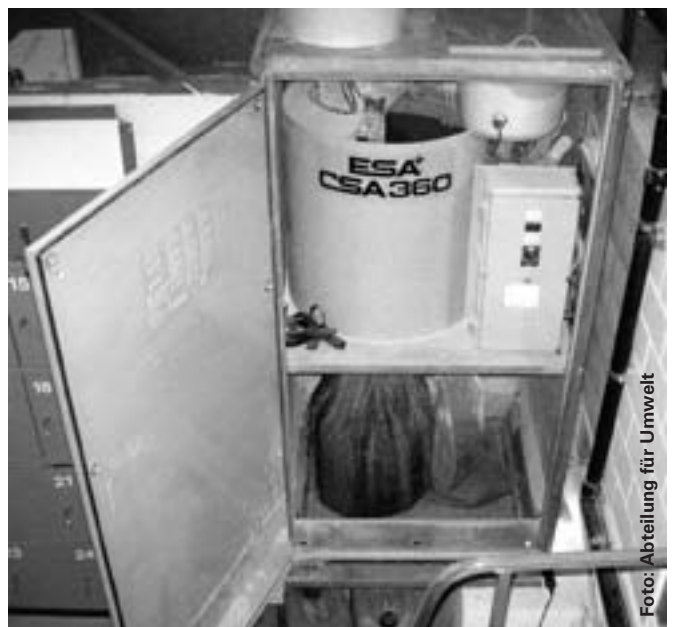
Diese Spaltanlage wurde nicht fachmännisch gewartet und unsachgemäss betrieben. Sie ist schmutzig und die Auffangbehälter überlaufen. Solche Spaltanlagen werden zum Entfernen von Ölen und Fetten aus dem Abwasser (Kohlenwasserstoffe) verwendet.
