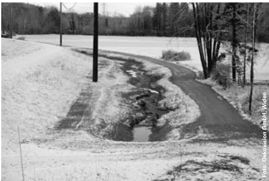
Links im Bild sind der neue Damm und die versetzte Freileitung im Rohrer Schachen zu sehen. Die Dammfussentwässerung wurde als naturnaher Giessen gestaltet.
