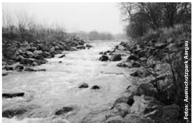
Für Fische war die Sohlschwelle in der Suhre vor dem Umbau unüberwindbar (rechts). Die neue durchgängige Blockrampe ermöglicht den Fischen nun den Aufstieg (links).
