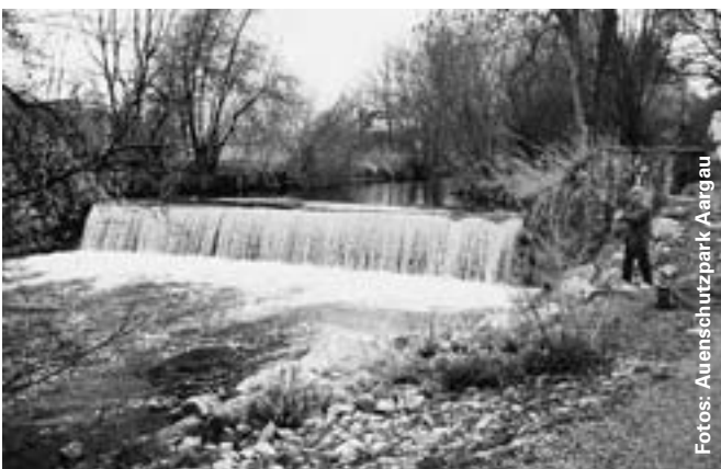
Für Fische war die Sohlschwelle in der Suhre vor dem Umbau unüberwindbar (rechts). Die neue durchgängige Blockrampe ermöglicht den Fischen nun den Aufstieg (links).
