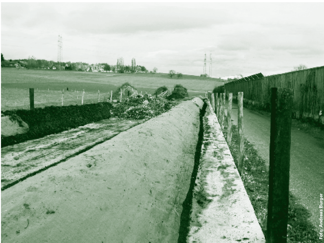
Neu erstellte Kompostieranlage in Safenwil
