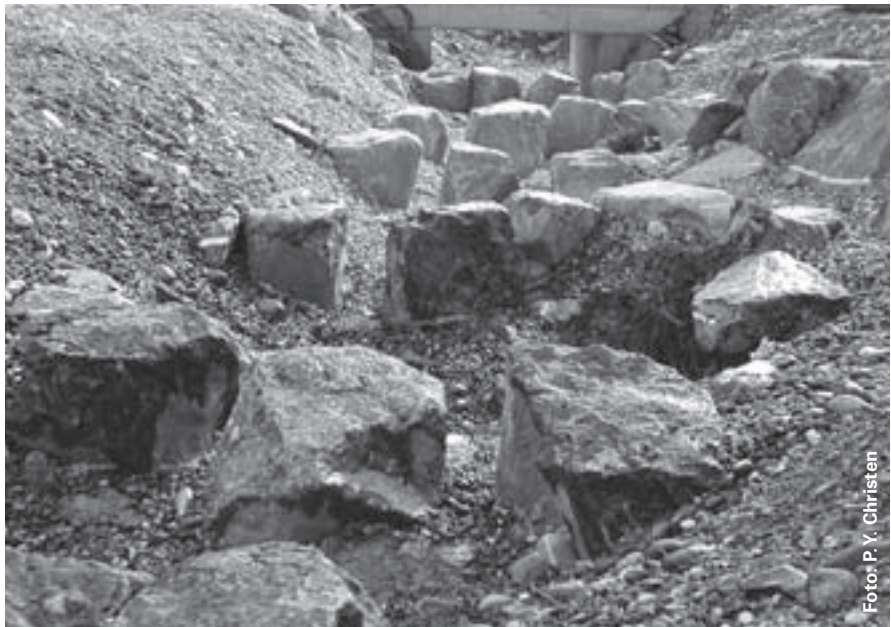
Eine so genannte «Fischtreppe» ermöglicht den Fischen den Aufstieg.
