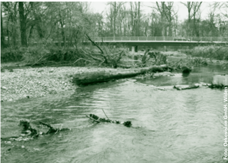
Der enge Durchlass für den Seitenarm Ausschachen ist rückgebaut worden. Unter der verlängerten Brücke ist Raum für mehr Dynamik.
