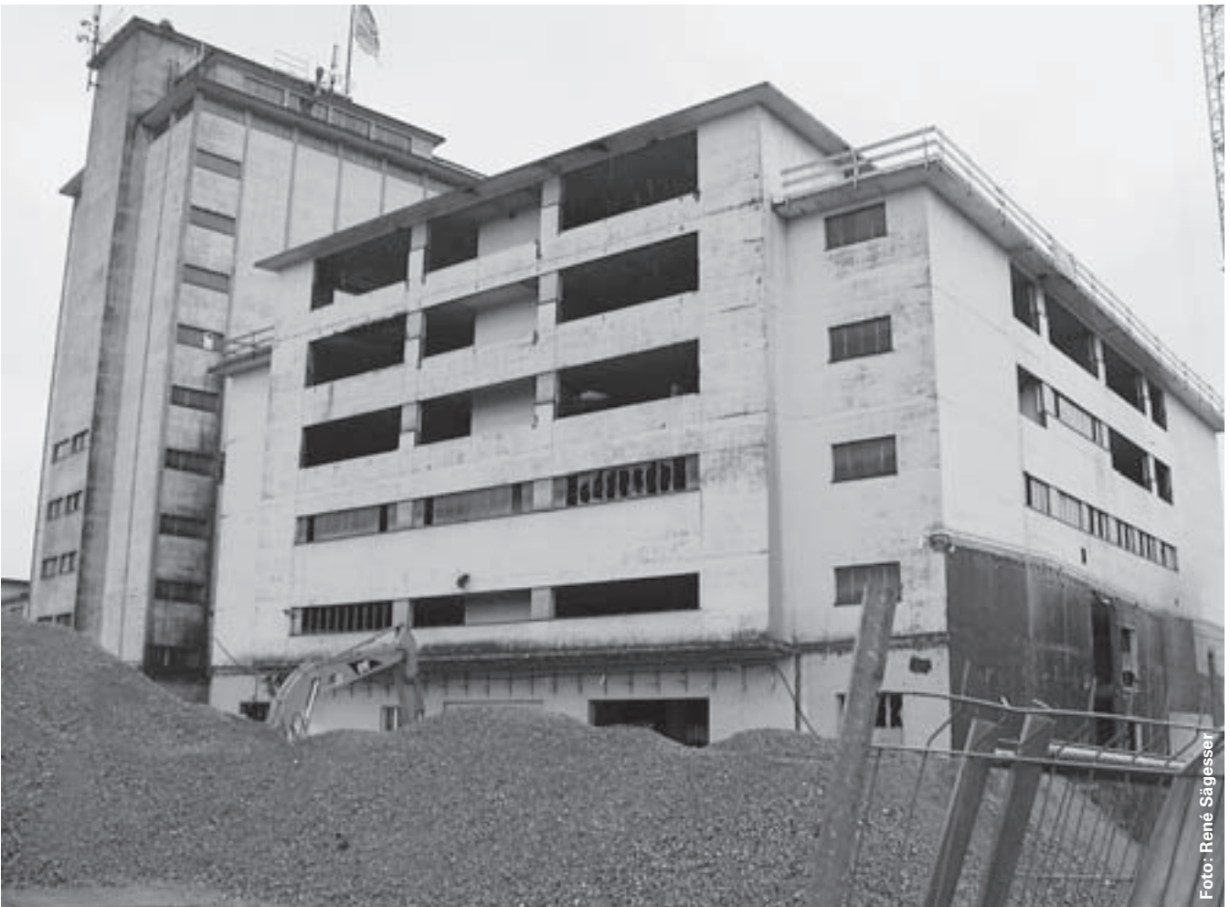
Die alte Mühle Lenzburg als Grossbaustelle
