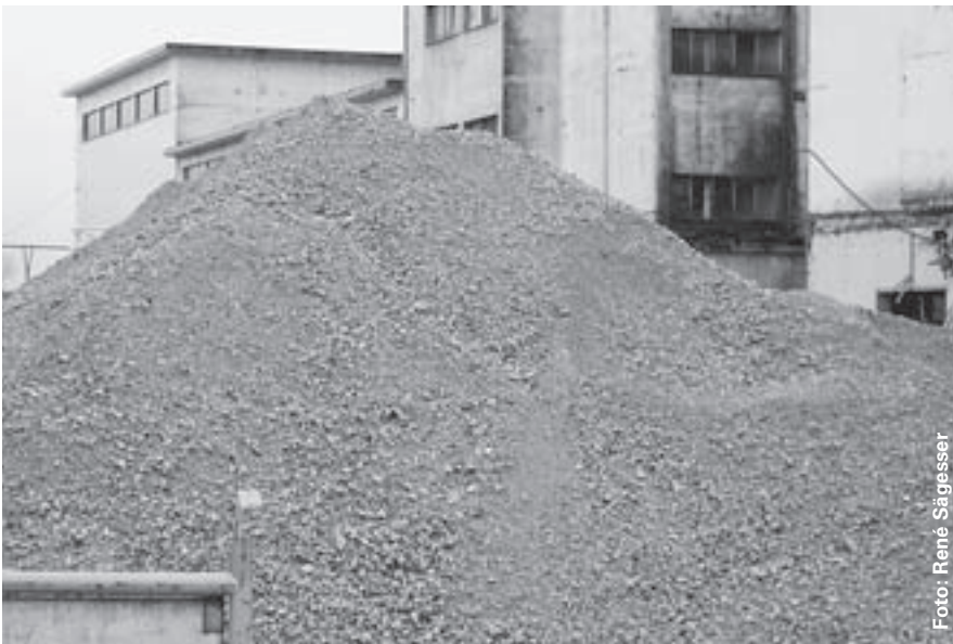
Das Betongranulat wird direkt vor Ort wieder eingebaut.
