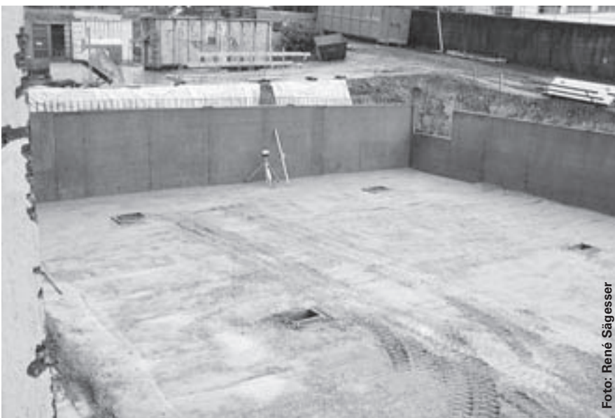
Das Betongranulat dient als Recyclingkieskoffer unter dem Betonboden der zukünftigen Tiefgarage.
