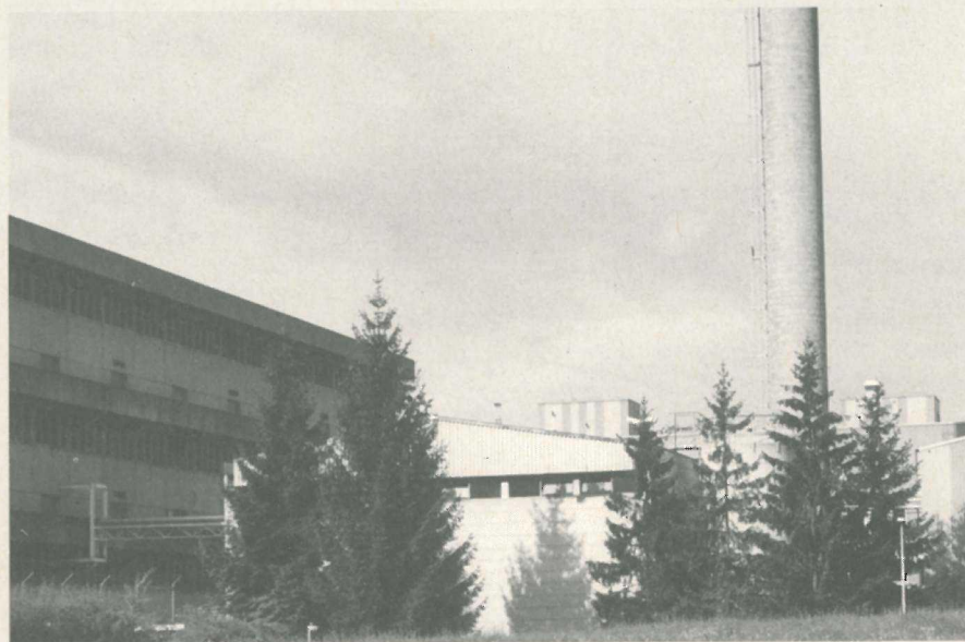
Ein gutes Beispiel für naturnahe Umgebungsgestaltung: Das Werkareal der Industriebauten der Ciba-Spezialitätenchemie in Kaisten.
