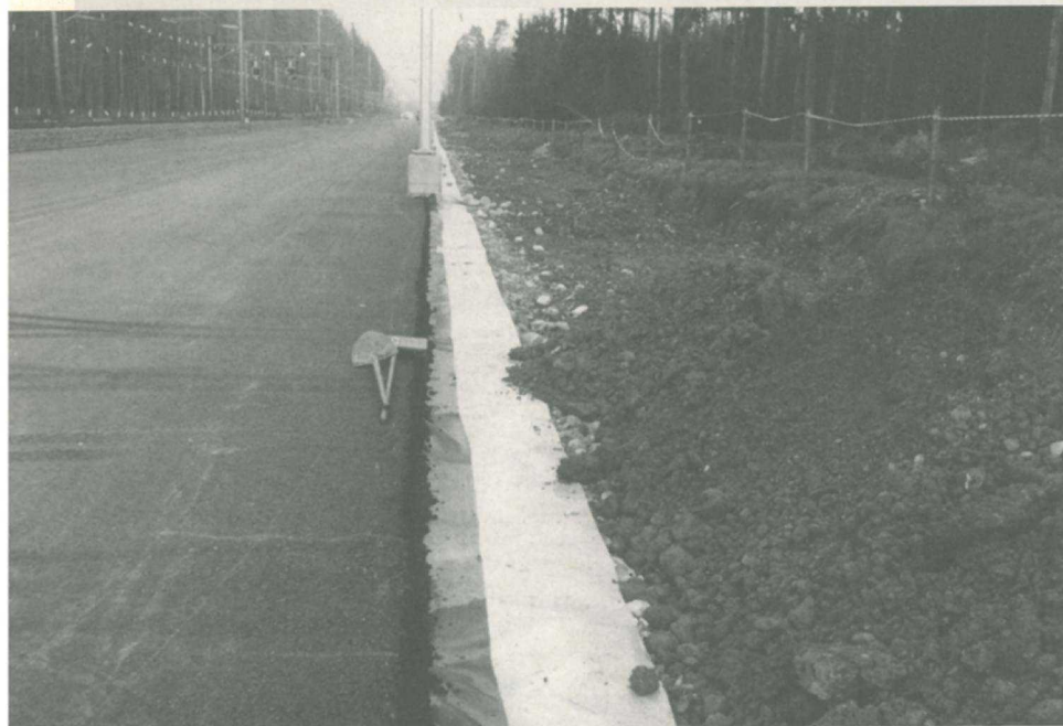
Beim Ausbau der SBB-Doppelspur Aarau-Ruppertswil wurde das Grundwasser durch Folienabdichtung geschützt.
