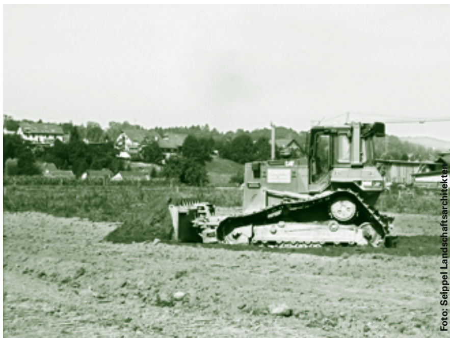
Bei trockener Witterung wird mit dem Dozer der Oberboden aufgetragen. Die beiden Raupen erzeugen nur einen geringen Bodendruck.
