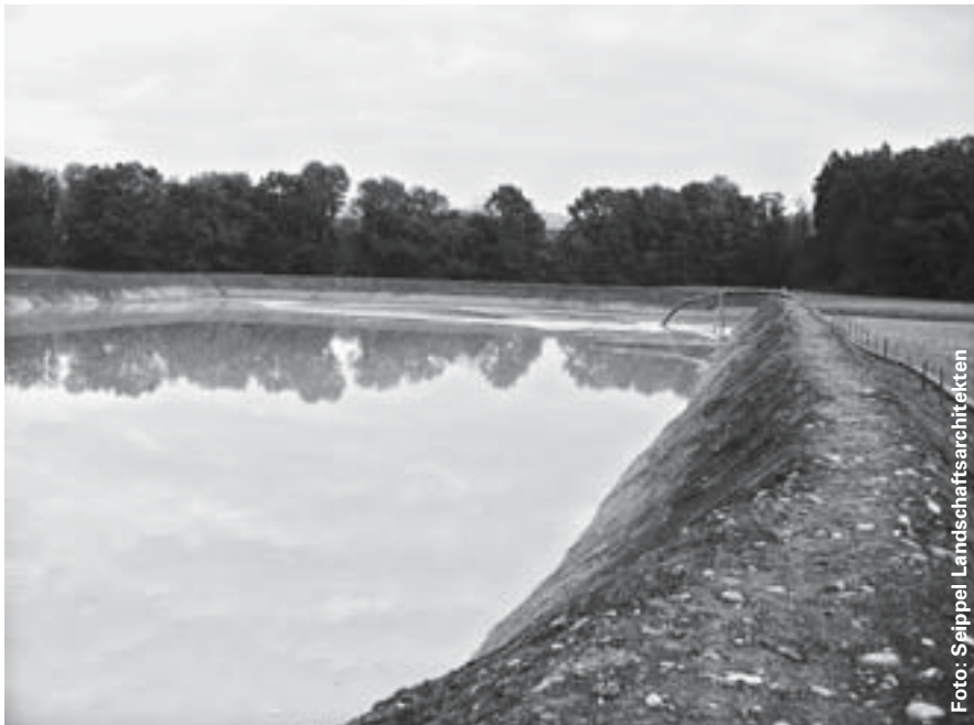
Der im Wasser gelöste Schlamm wird in ein Becken gepumpt. Während der Schlamm sich absetzt, wird das überschüssige Wasser wieder in den Altlauf zurückgeführt.
