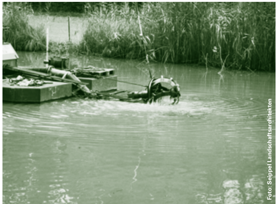
Der Bohrkopf des Saugbaggers löst den zähen Schlamm und saugt ihn zusammen mit Wasser ab.
