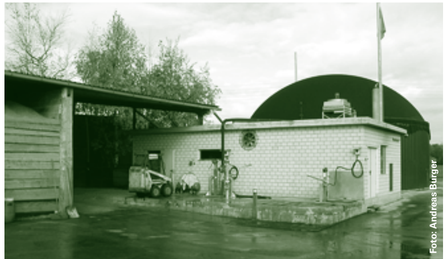
Die neue Co-Vergärungsanlage in Oberrüti
