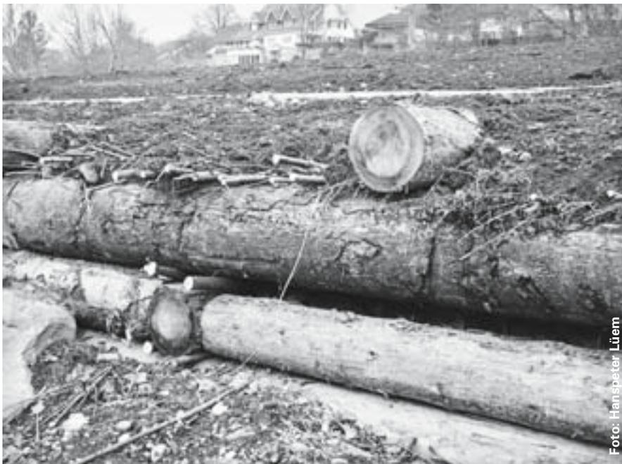
*Weidenstecklinge in der Stirnseite des Holzkastens sorgen für eine schnelle Begrünung und eine zusätzliche Verfestigung der Uferböschung.*
