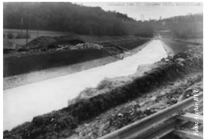
Der neue Bünzkanal nach einem Hochwasser in Othmarsingen 1935 (Blick von der Strassenbrücke Richtung Bahndamm)
