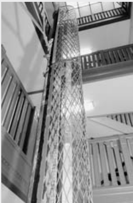
Schwanenpegel mit Schauglas. Der schwankende Druckpegel liegt rund 10 m über dem Quellstock.
