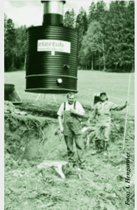
Die neue Brunnenstube wird gesetzt.
