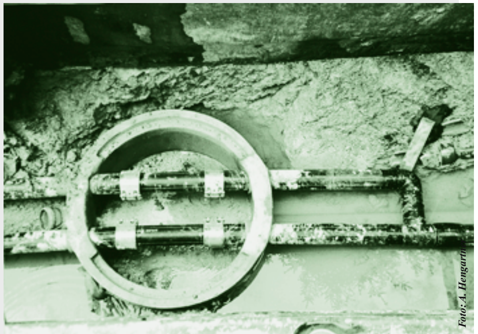
Chriegholz: Kontrollschacht neu in etwa vier Meter Tiefe
