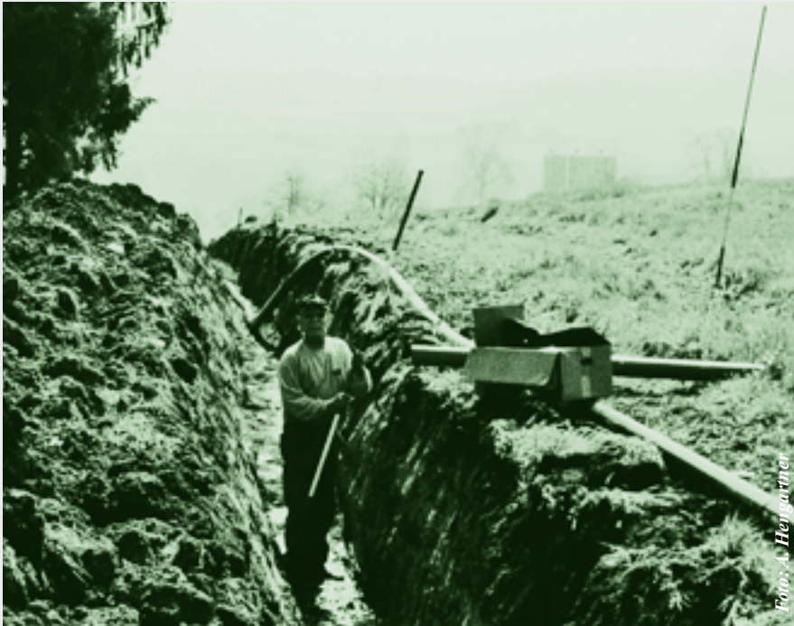
Die neuen Rohre werden verlegt.
