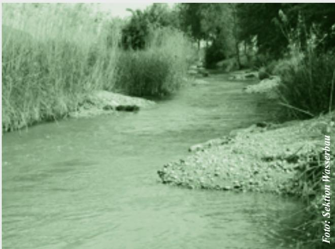
Die buhnenartig eingebrachten Störsteine und die Kies-schüttungen ermöglichen eine höhere Strömungsvielfalt.
