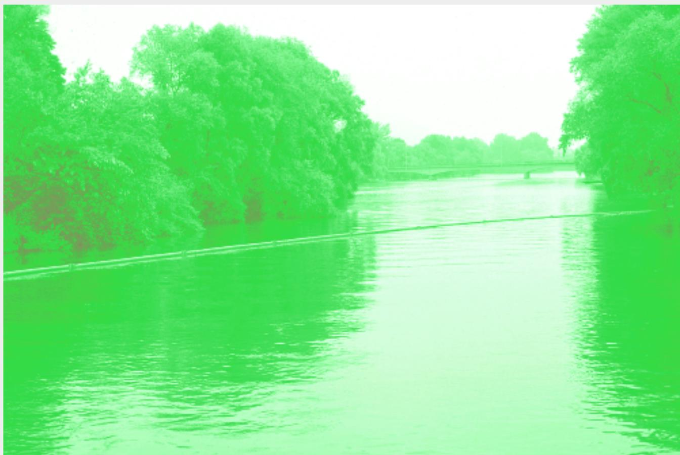
*Der Einsatz der mobilen Ölsperren ist von den hydraulischen Verhältnissen abhängig. Um eine gute Wirkung zu erzielen, sollte die Fliessgeschwindigkeit möglichst gering sein. Der Einbau der Sperre auf den Flüssen erfolgt meist an einer der rund 20 vorbereiteten und periodisch geübten Einsatzstellen.*
