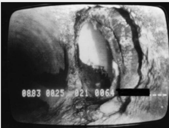
*Das Kanalfernsehen ermöglicht es, schadhafte Kanalisationsanschlüsse zu finden.*
