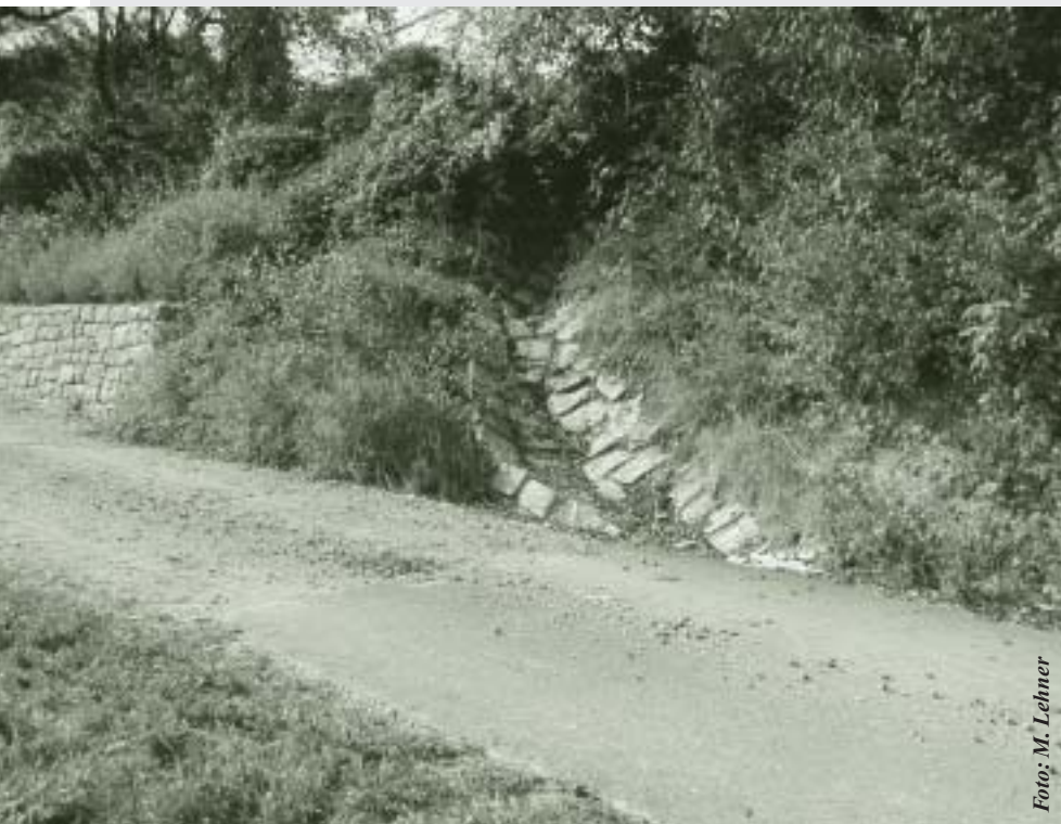
Erneuerter Flurweg mit Trockenmauer und Wasserabfuhr in Küttigen
