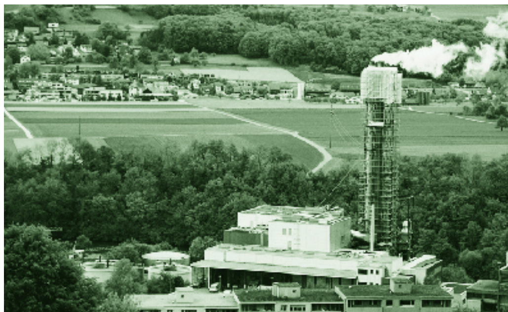
Böden in der Nähe von Industriebetrieben können mit Schadstoffen belastet sein. Foto: Niederer + Pozzi
