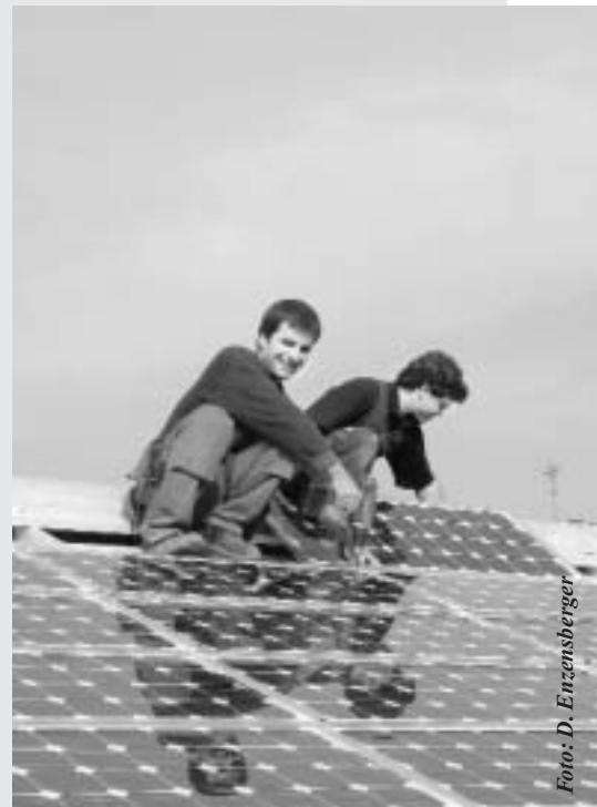
Montage der Solarmodule als neue Dachhaut.
