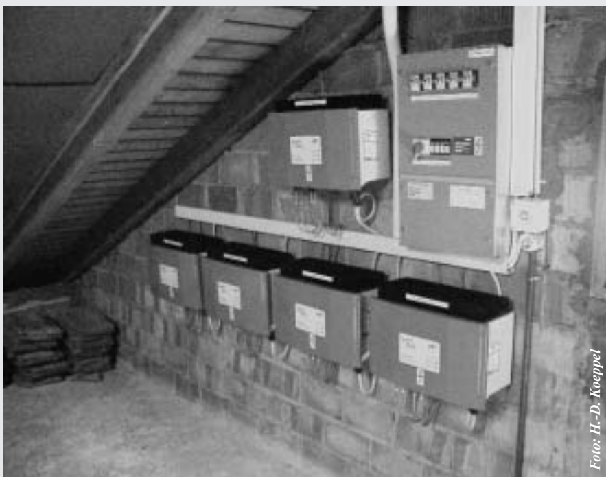
Die Installationen unter dem Dach mit je einem Wechselrichter für 30 Module.
