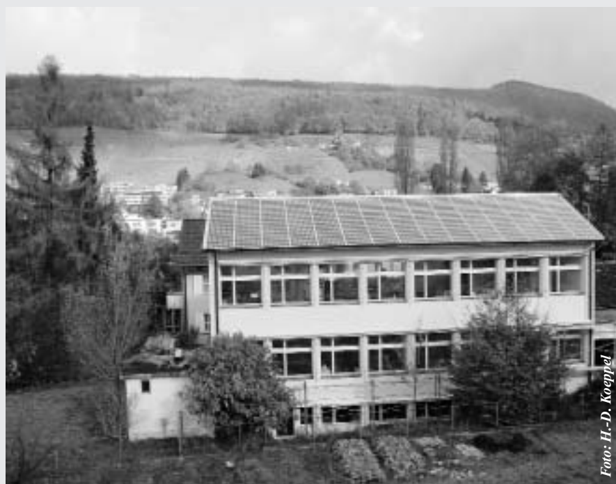
Die Modul-Rasterung ist auf die bestehende Fassade ausgerichtet. Die neuzeitlichen Materialfarben, welche eine Eloxierung ersetzen, werden ebenso gezeigt wie die First- und Randabschlüsse. Die dunkle Kupferdachrinne integriert sich gut in die Dachlandschaft.
