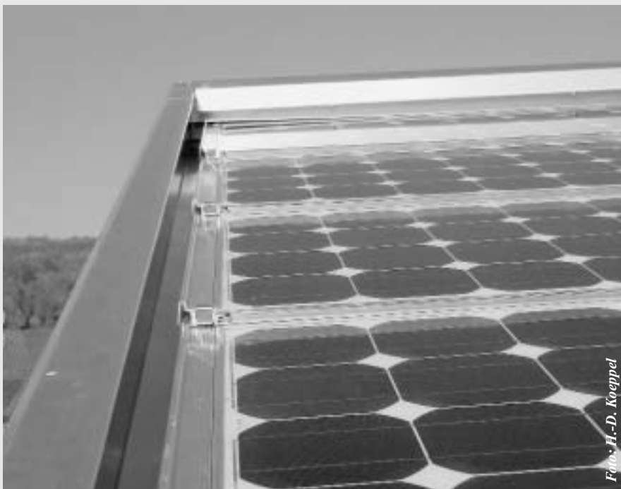
Alle Abschlüsse sind aus einem speziellen Chromstahlblech angefertigt und so farblich gut abgestimmt auf die Aluminiumrahmen und die weissen Raster der Module, die in einem dunklen Blau-Schwarz gewählt wurden.
