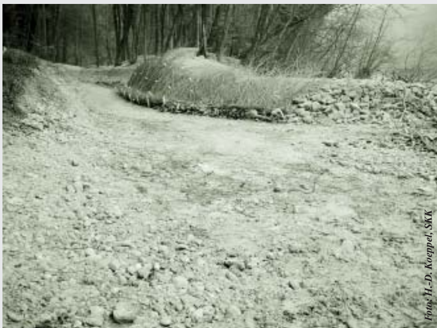
Unmittelbar nach Beendigung der Bauarbeiten, vom gleichen Standort aus: Die Rinne wurde vertieft, der Aushub seitlich abgelagert. Noch ist das Bett trocken, noch ist die Uferlinie gleichmässig...
