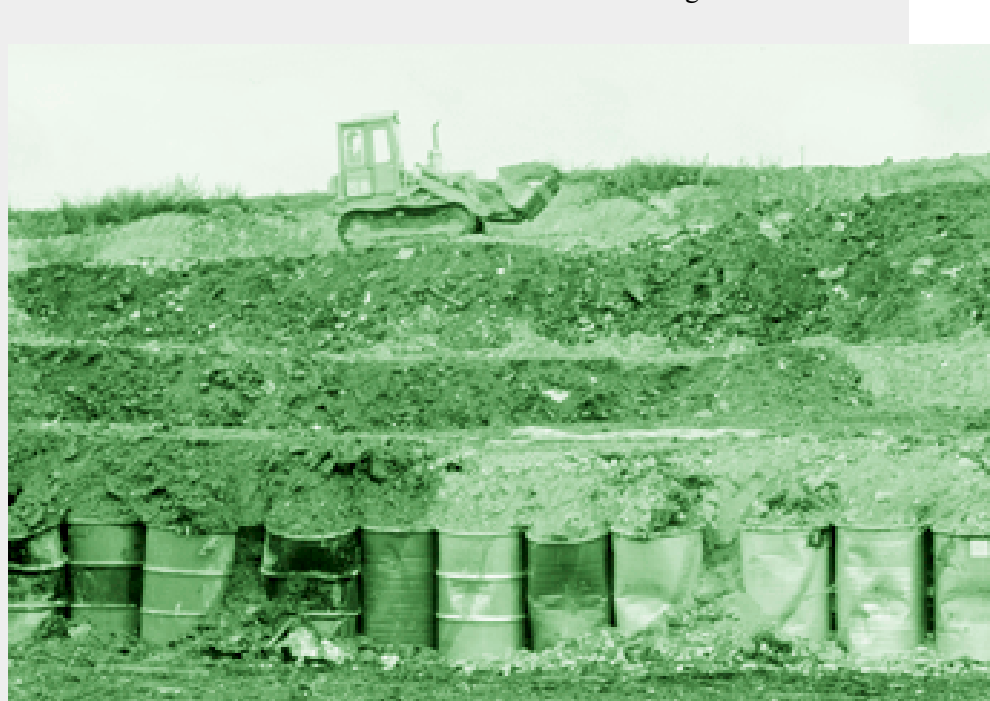
Einbau von Fässern in der Sondermülldeponie Kölliken während der Betriebsphase von 1979 bis 1985
