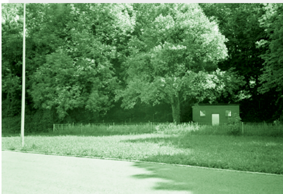
Dank einer Landumlegung konnte dieses Grundwasserpumpwerk in Sisseln einer eigenständigen Parzelle der Einwohnergemeinde zugeteilt werden.
