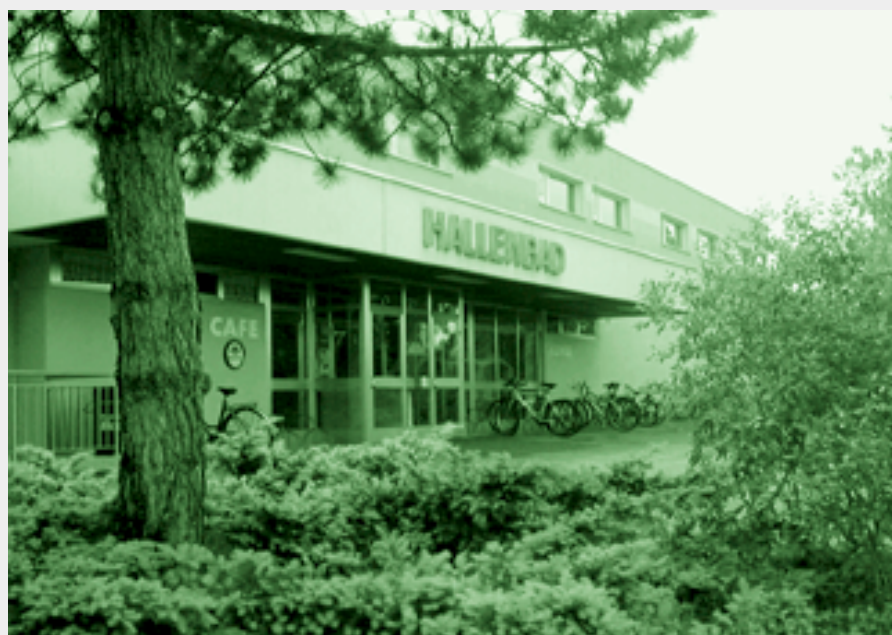
Hallenbad Seon: Der Wärmebedarf wird durch die benachbarte Trinkwasserversorgung gewährleistet.
