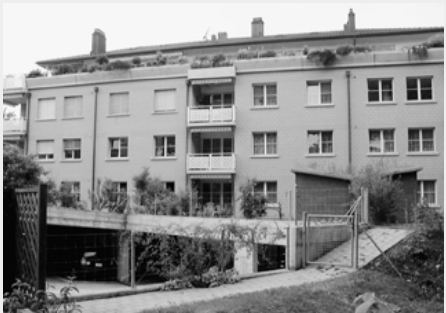
Im Gebiet Bachmatt wird mit umweltfreundlicher Erdwärme (fern)geheizt.
