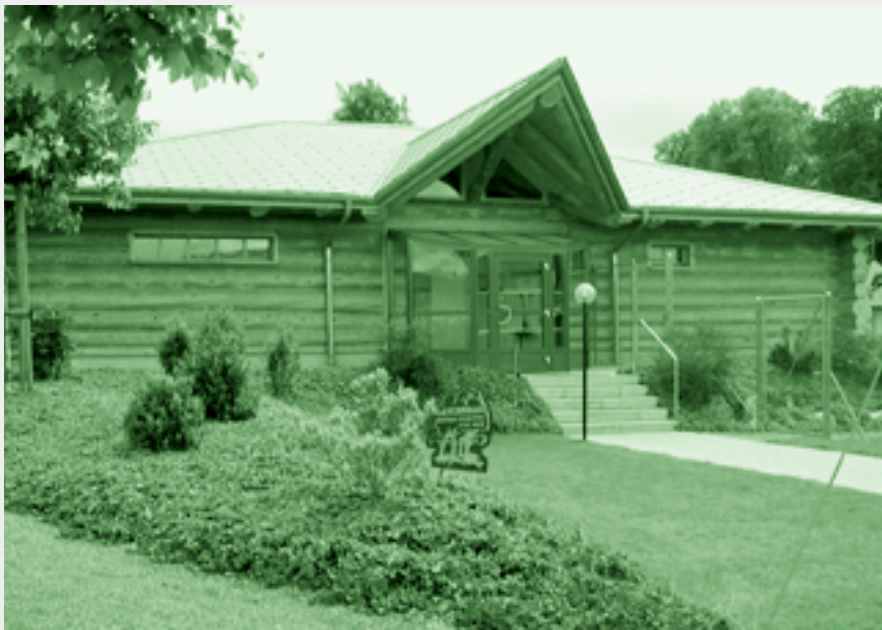
Auch die Blockhaussauna beim Hallenbad wird mit Fernwärme beheizt.
