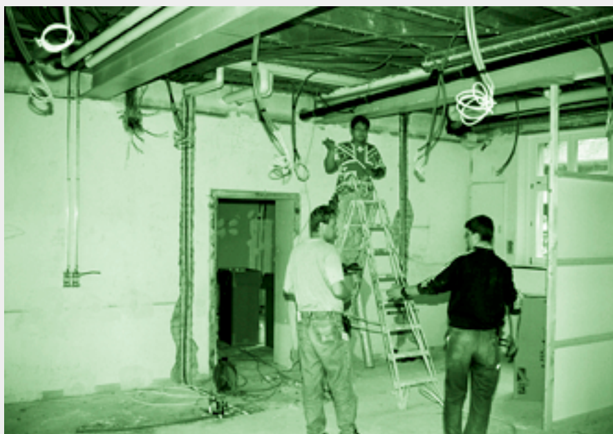
Umbauarbeiten für das neue Labor der Abteilung Umweltschutz
