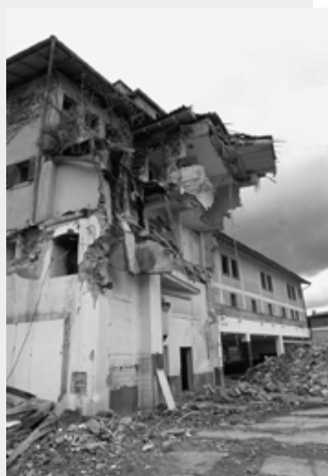
Überreste des alten Laborgebäudes
