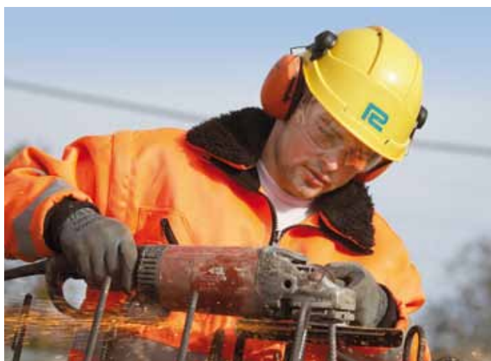
Die Arbeit im Baugewerbe bringt hohe Risiken für die Arbeitnehmer. Deshalb sind Schutzmassnahmen besonders wichtig.
