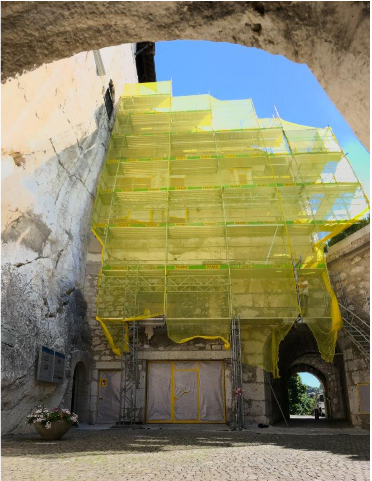
Sanierung Westfassade Ravelin: Anbringen von mineralischem Putz
