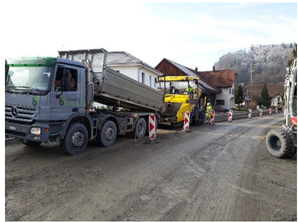
Abb. 4: Einbau Feinplanie Fahrspur Richtung Staufen
