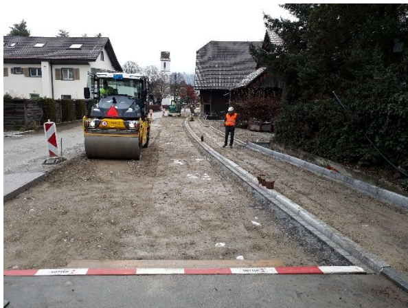
Abb. 3: Erstellung Rohplanie Fahrspur Richtung Staufen inkl. Verdichtung
