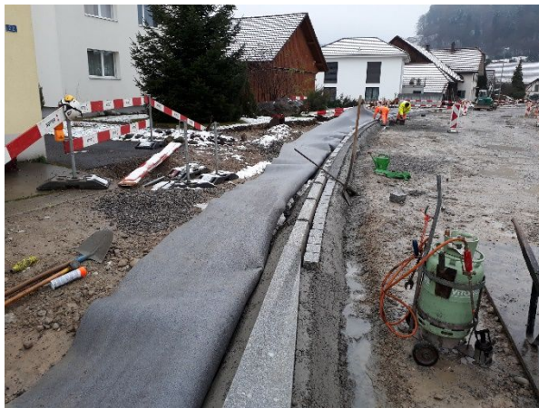
Abb. 1: Ausfugen Randabschlüsse Fahrbahn / Gehweg
