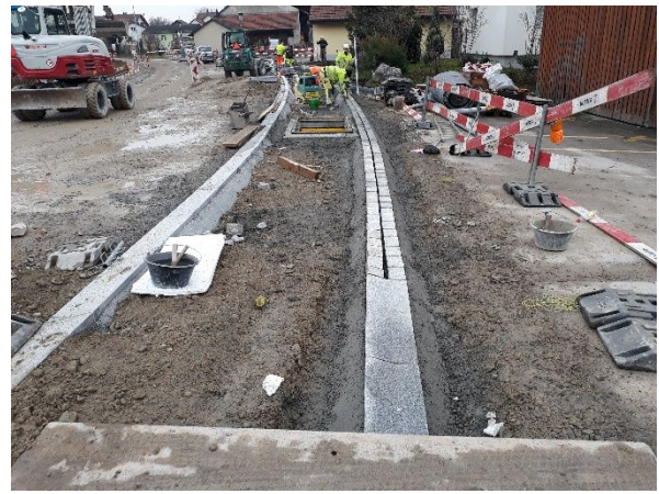
Abb. 2: Versetzen Randabschlüsse Hinterkante Gehweg
