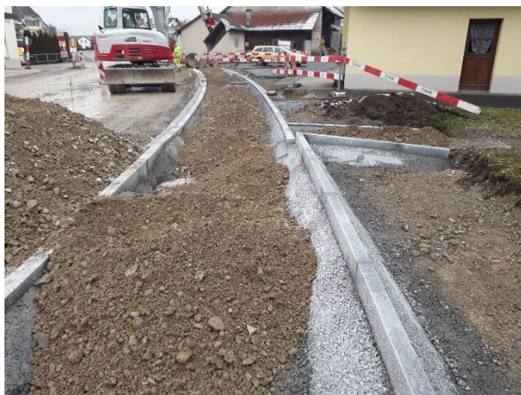
Abb. 5: Erstellung Rohplanie Gehweg
