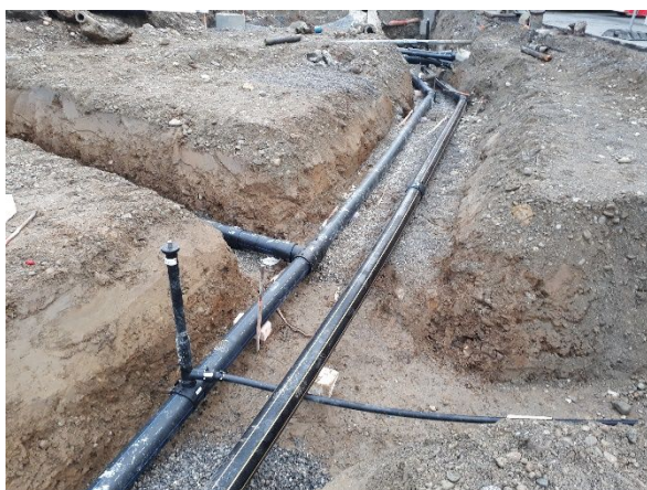
Abb. 5: Verlegung neue Werkleitungen Wasser + Gas
