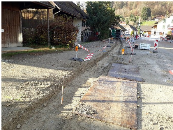
Abb. 1: Absteckung Randabschlüsse Fahrbahn / Gehweg
