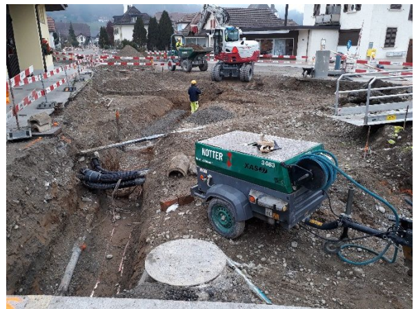
Abb. 4: Grabenaushub Werkleitungen Wasser, Gas, Elektro
