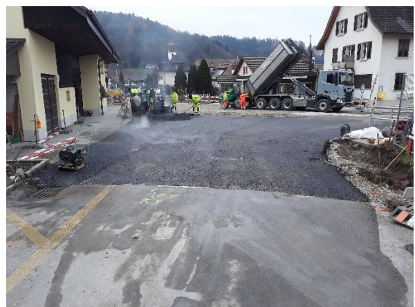
Abb. 6: Einbau prov. Belag Einlenker Staufbergweg
