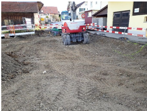
Abb. 3: Abtrag best. Foundationsschicht Einlenker Staufbergweg
