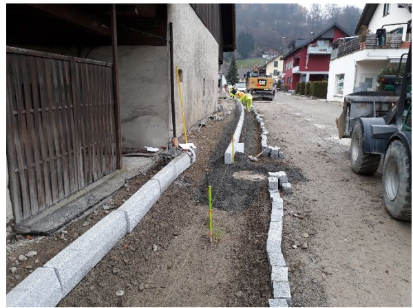
Abb. 2: Versetzen Randabschlüsse Fahrbahn / Gehweg
