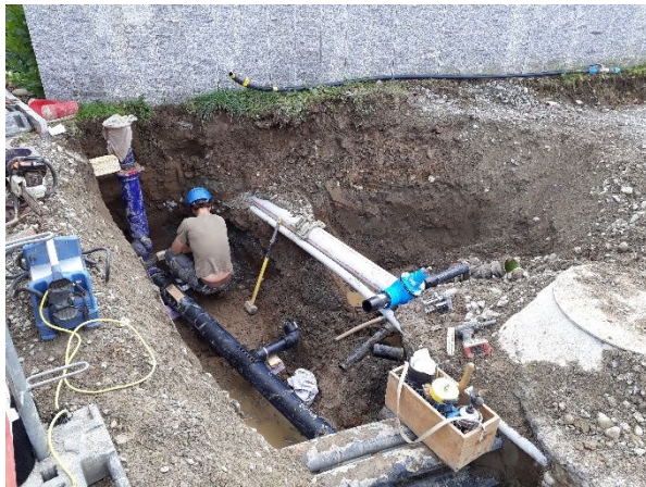
Abb. 3: Versetzen Wasser Hydrant
