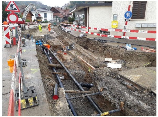
Abb. 4: Verlegung Werkleitungen Wasser + Gas
