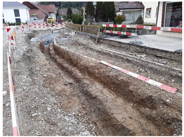
Abb. 2: Aushub Kombigraben WL WA, GA, Medienrohr
