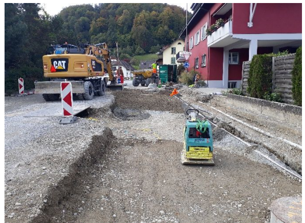
Abb. 6: Einbau + Verdichtung neue Fundationsschicht
