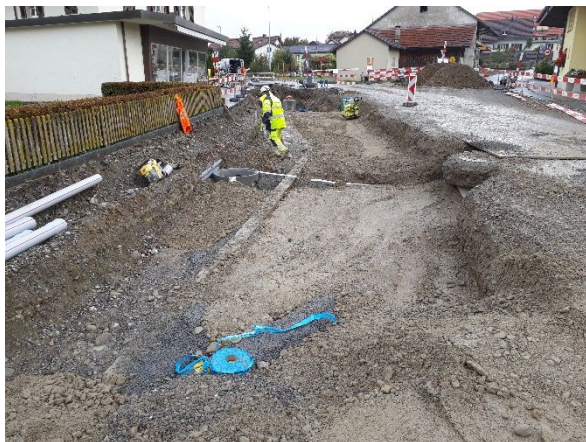
Abb. 5: Grabenauffüllung
