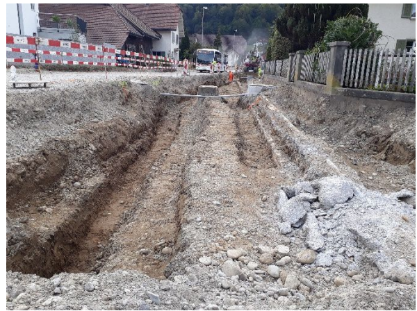
Abb. 2: Aushub Kombigraben WL WA, GA, Medienrohr
