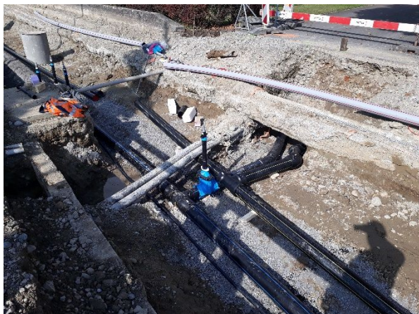
Abb. 3: Verlegung Werkleitungen Wasser + Gas
