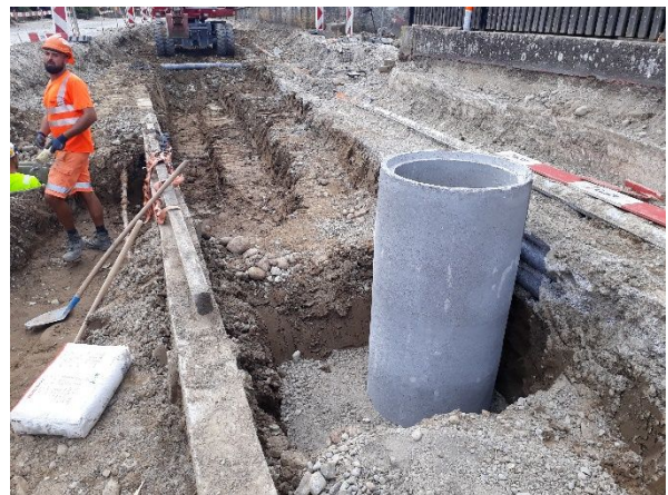
Abb. 4: Versetzen von Strassenabläufen
