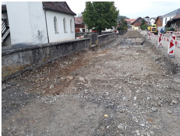
Abb. 1: Abtrag best. Foundationsschicht
