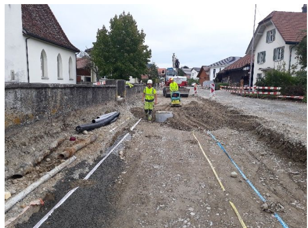
Abb. 6: Einbau + Verdichtung neue Foundationsschicht
