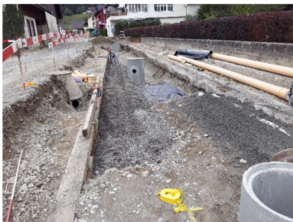
Abb. 5: Grabenauffüllung und Materialersatz Planum
