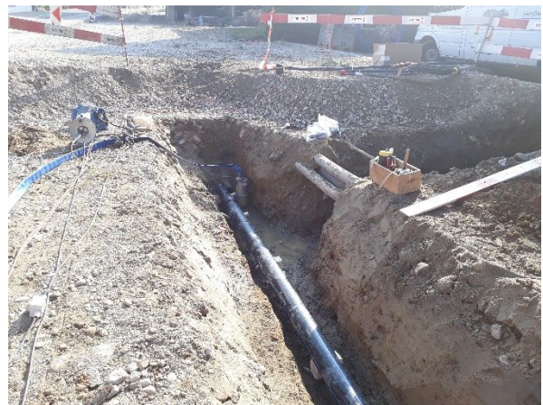
Abb. 4: Werkleitungsarbeiten Wasser + Gas
