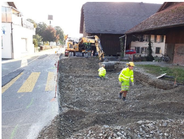
Abb. 3: Abtrag best. Fundationschicht
