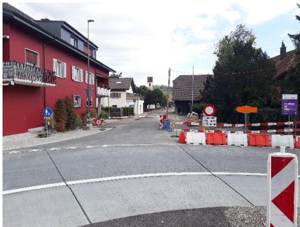
Abb. 1: Einrichtung / Umleitung Baustelle Teilprojekt 3
