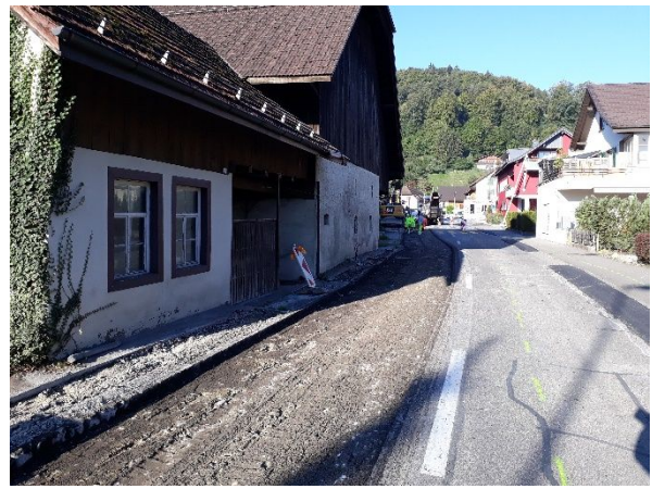
Abb. 2: Abbruch best. Belag (Fräsarbeiten)
