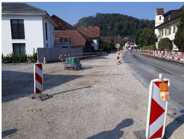
Abb. 5: Einbau / Verdichtung neue Fundationschicht
