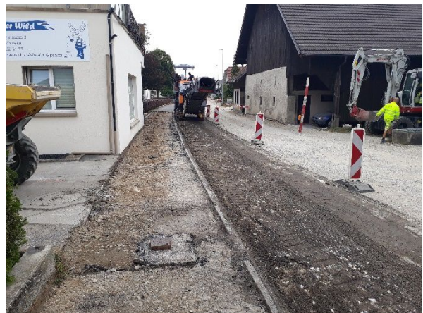
Abb. 6: Phasenumstellung 3.2 / Abbruch best. Belag
