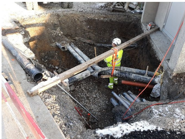
Abb. 3: Fertigstellung Aushubarbeiten Spezialkabelschacht Elektro vor Trafostation Ausserdorf
