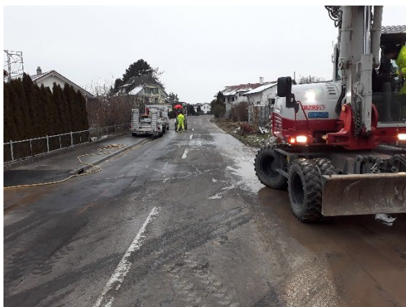
Abb. 5: Frässchnitte entlang der Gehwege Richtung Grütstrasse
