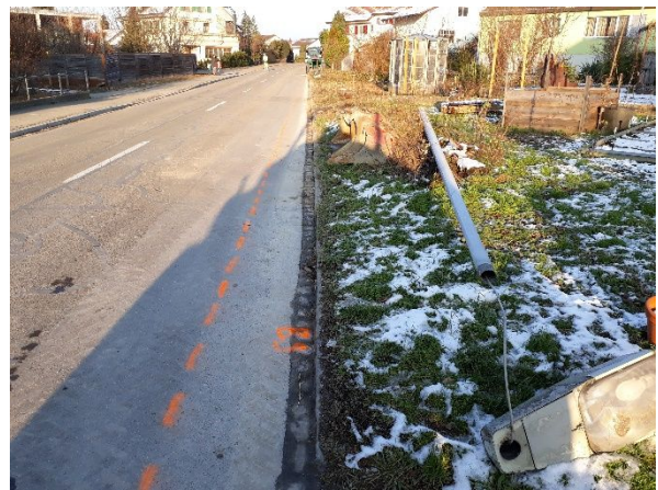
Abb. 4: Rodungsarbeiten und Demontage Kandelaber Bereich neuer Gehweg Richtung Grütstrasse
