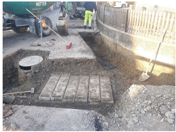
Abb. 2: Freilegung best. Kabelschacht Swisscom
