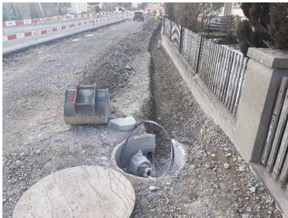
Abb. 1: Grabenaushub Swisscomleitungen Hüttmattstrasse bis Schopfweg
