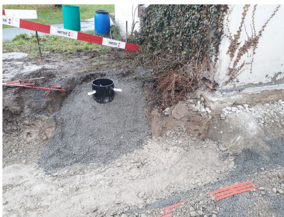
Abb. 5: Versetzen neue Kandelaberfundamente
