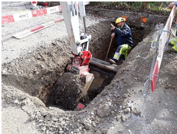
Abb. 1: Grabenaushub für Werkleitungen Wasser + Gas
