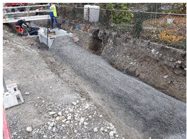
Abb. 6: Erstellung Rohrblockanlage EW
