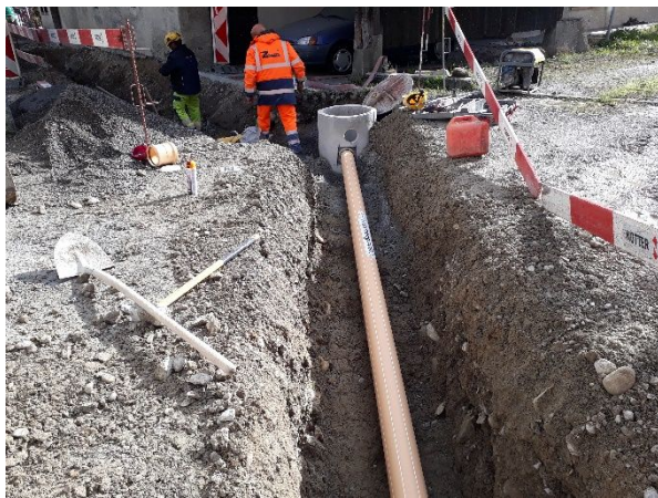
Abb. 3: Versetzen Strassenablauf und Erstellung Entwässerungsanschluss
