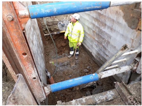
Abb. 4: Grabenaushub inkl. Spriessung vorsorglicher Kanalisationsanschluss Drittprojekt Stapfenweg
