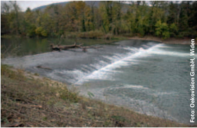
Eine Sohlschwelle in der Aare erschwerte den Wanderfischen den Aufstieg (links). Durch den Umbau in eine aufgelöste Blocksteinrampe (rechts) wurde die Längsvernetzung wieder hergestellt.
