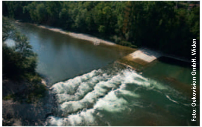
Eine Sohlschwelle in der Aare erschwerte den Wanderfischen den Aufstieg (links). Durch den Umbau in eine aufgelöste Blocksteinrampe (rechts) wurde die Längsvernetzung wieder hergestellt.
