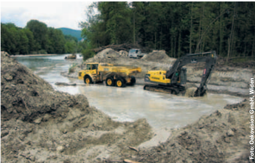
Die Restwasserstrecke des Kraftwerks Rapperswil-Auenstein wurde dynamisch gestaltet: Uferverbauungen wurden entfernt, das Terrain abgesenkt, Kiesbänke geschüttet und Strukturen im Flusslauf eingebaut.
