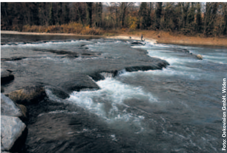
Hier stand eine Sohlschwelle, welche für Fische schlecht zu überwinden war. Im Februar 2010 wurde sie in eine fischgängige Teilrampe umgebaut.
