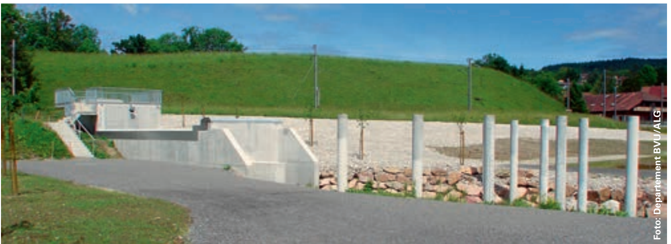
Das Auslaufbauwerk des Hochwasserrückhaltebeckens Moos
