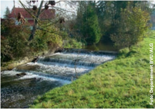
Längsvernetzung vorher (links) und nachher (rechts): Die aus ökologischer Sicht problematischen Querverbauungen wurden rückgebaut oder so umgestaltet, dass die Wyna wieder «fischgängig» wurde.
