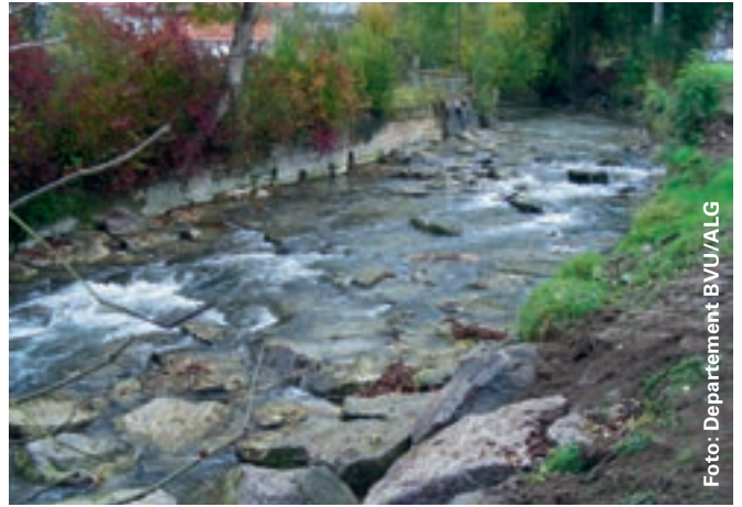
Längsvernetzung vorher (links) und nachher (rechts): Die aus ökologischer Sicht problematischen Querverbauungen wurden rückgebaut oder so umgestaltet, dass die Wyna wieder «fischgängig» wurde.
