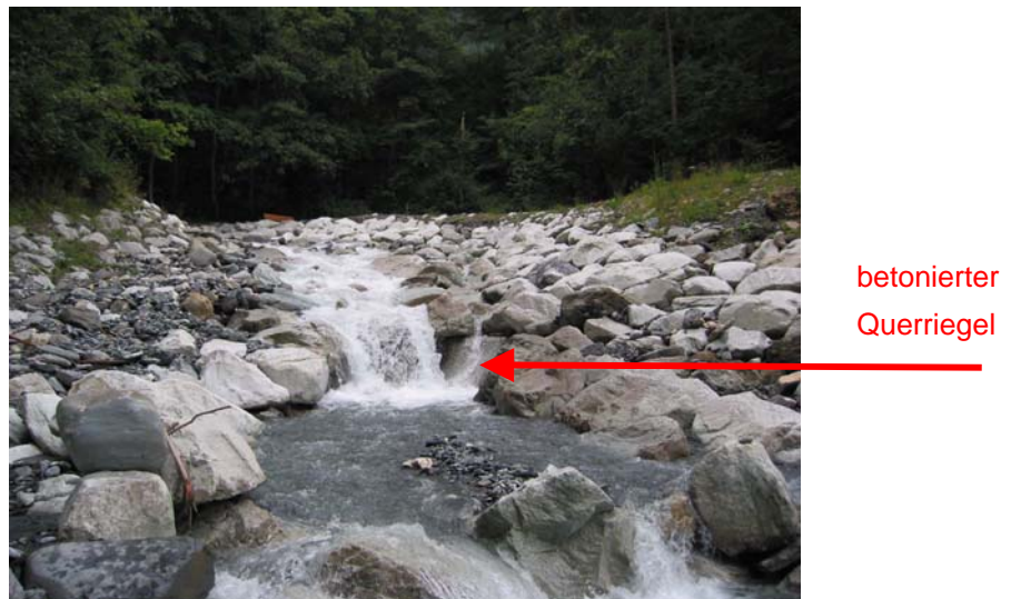
Abb. 11: Beispiel für eine zerstörte Rampe an der Dala
