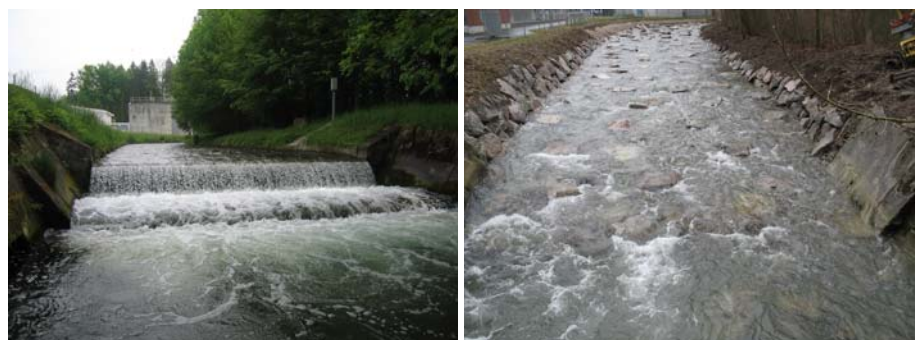
Abb. 1: Aabach bei der ARA Seengen: Nicht durchgängiger Absturz (links) und Rampe nach der Sanierung (rechts)
