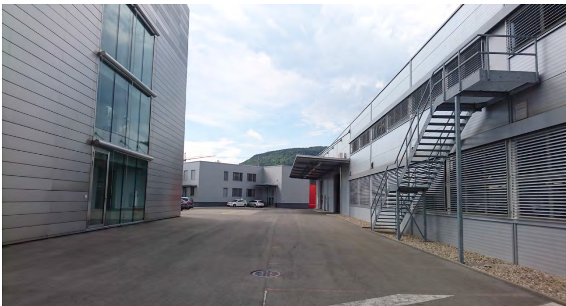
Typische Blechfassaden auf dem Areal. Im Hintergrund: Das älteste, noch bestehende Gebäude mit neuer Blechhaut.
