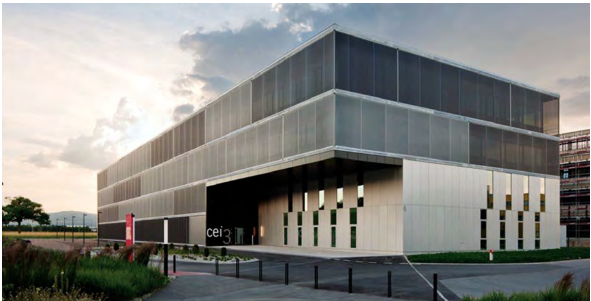
Das Gebäude CEI3 an der Rue Galilée. Quelle: http://www.weinmann-energies.ch/references_page/eca-cei-3-rue-galilee-6-centre-d-entreprise-et-d-innovation-yverdon-les-bains/ .
