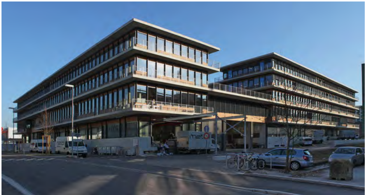
Die Vorzone dient rundum konsequent als Vorfahrt und Anlieferung. Quelle: www.met-all.ch/kontakt/140-anfahrt-zum-noerd .
