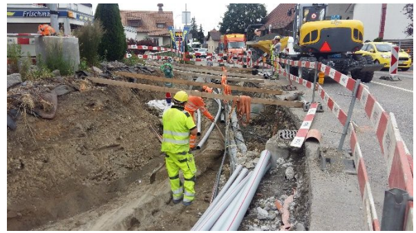
Abb. 2: Werkleitungsbau Pizzeria Samoo's
