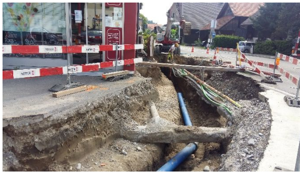
Abb. 1: Werkleitungsarbeiten Metzgerei Merz
