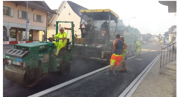
Abb. 4: Einbau Tragschicht
