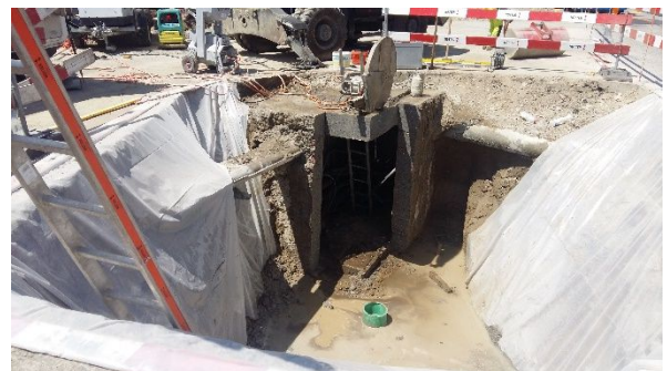
Abb. 6: Bau Swisscomschacht Kreisel
