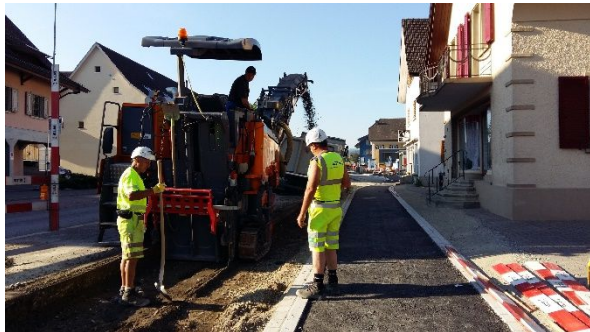
Abb. 3: Abfräsen des bestehenden Belags
