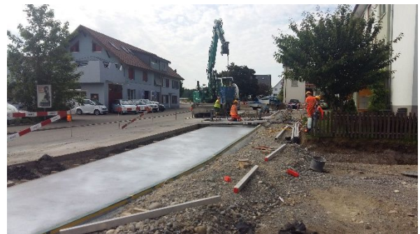
Abb. 4: Betonieren der Busplatte Milchgasse West
