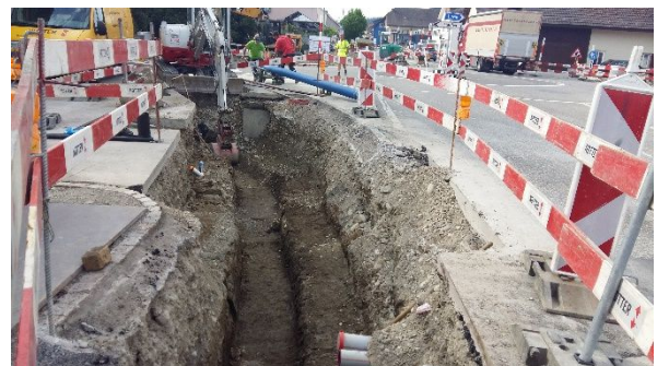
Abb. 6: Werkleitungsarbeiten Metzgerei Merz
