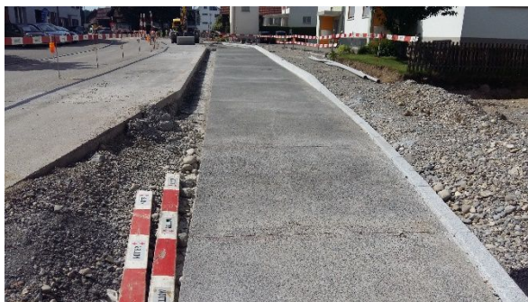
Abb. 5: Fertige Betonplatte Milchgasse West
