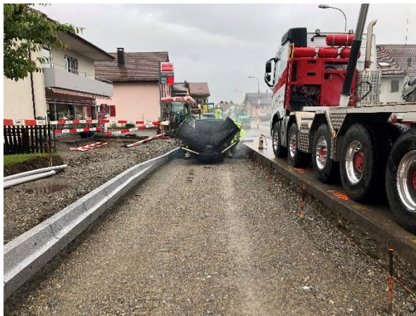
Abb. 1: Erstellung Tragschicht Bushaltestelle
