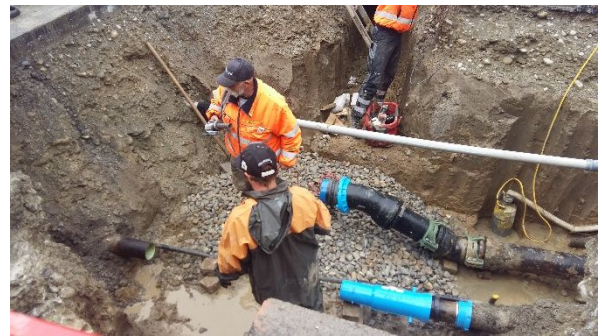
Abb. 4: Erstellung Wasserschieber Metzgerei Merz
