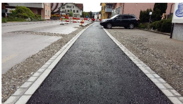
Abb. 5: Randabschlüsse Bäckerei Richtung Talgasse
