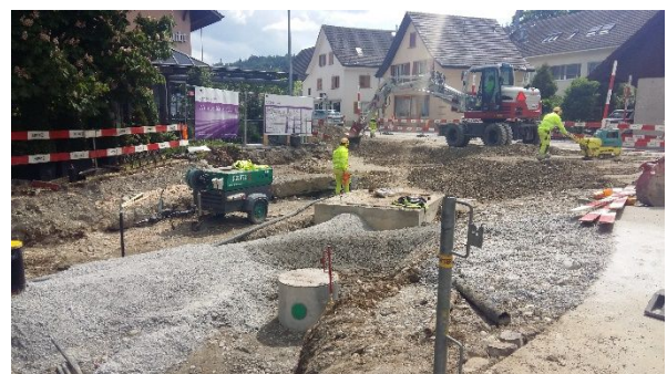
Abb. 6: Werkleitungsarbeiten Vorplatz Rest. Eintracht
