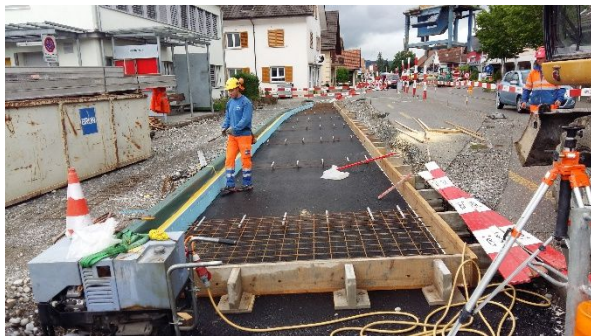
Abb. 3: Vorbereitung Betonbauarbeiten Gemeindeplatz
